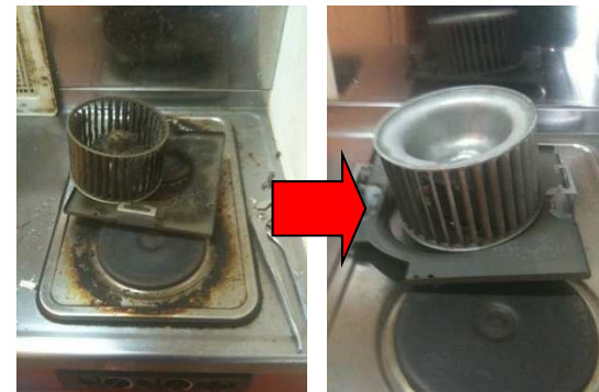
キッチンの換気扇 シロッコファン
